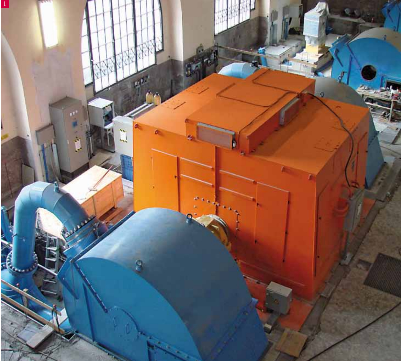
1 32.000 kVA 600 rpm, 12.000 V. Italia
